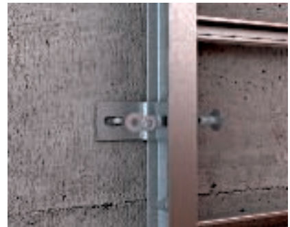
Industriālo vertikālo kabeļu trepju nostiprināšana Industriālo vertikālo kabeļu trepju nostiprināšanu pie sienas veic ar BW80/55 tipa stiprinājuma leņķiem.
