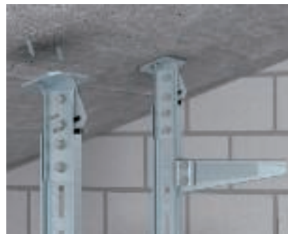
Variējama augšējā plāksne (pagriezta par 90°) KI 8 VKL tipa pielāgojamās, par 90° pagrieztās traverša plātnes montāža pie slīpiem betona griestiem ar enkurtaipām.
