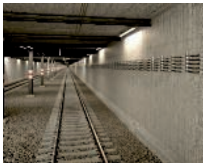
Kabeļu stiprinājuma iedobes tiek izmantotas vietās ar ierobežotu montāžas telpu, piemēram, metro vai apgādes tuneļos.
