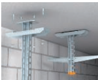
Adaptora augšējā plāksne, simetriska Simetriska augšējā plāksne KA-SY nestspējas palielināšanai kombinācijā ar US 7 K un IS 8 K tipa iekārtajiem statņiem.
