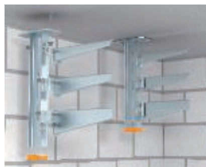
Balsteņa montāža 3 līmeņu kabeļu nesošās sistēmas montāža pie betona griestiem ar statņa balsteni AS 15, AS 30 un AS 55.
