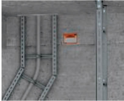
Virziena maiņas pielietojums SKM tipa smāgas konstrukcijas vertikālo kabeļu trepju virziena maiņa.
