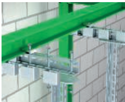
Konsole ar iekārtu statni Pie tērauda sijas piestiprināta konsole no U-veida statņa konstrukcijas iekārtu statņu montāžai.
