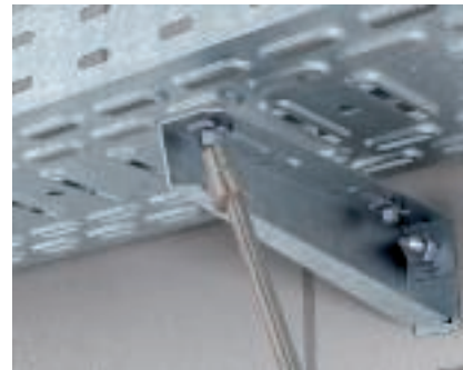
Renes ātra nostiprināšana uz balsteņa Kabeļu renes nofiksēšana uz balsteņa ar ātro stiprinājumu.
