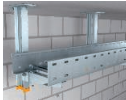
Gara laiduma kabeļu trepju nostiprināšana Gara laiduma kabeļu trepju nostiprināšana uz balsteņa ar LKS 60/5 tipa fiksatoru.
