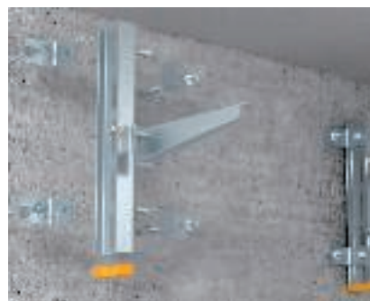
I-veida statņa nostiprināšana pie sienas I veida statņa montāža pie sienas, izmantojot BW 80/55 tipa stiprinājuma lēņņus un enkurtaipas, lai varētu uzņemt vairākus AS tipa statņu balsteņus.
