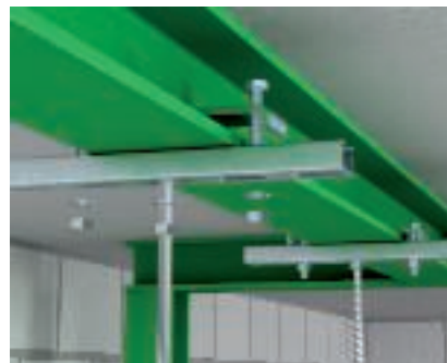
C profila sliedes nofiksēšana pie tērauda sijas CPS 4 G vai CPS 5 G tipa C profila nostiprināšana pie tērauda sijām ar KWS fiksācijas leņķiem.
