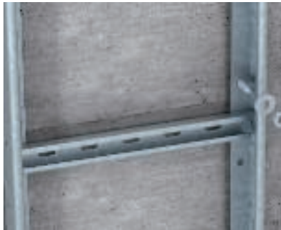
Tieša montāža pie sienas Vertikālo kabeļu trepju LG un SSL nostiprināšana pie sienas ar enkurskrūvēm.
