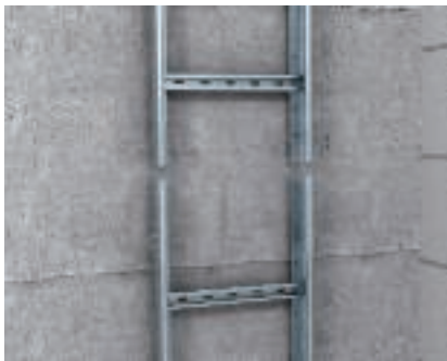
Vertikālo kabeļu trepju garenais savienojums LG un SSL 60 tipa vertikālo kabeļu trepju savienošana ar LVG tipa savienotāju.
