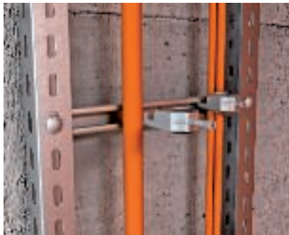
Vadu nostiprināšana ar piekarapskavu Vadu nostiprināšana pie spraišļa ar piekarapskavām.
