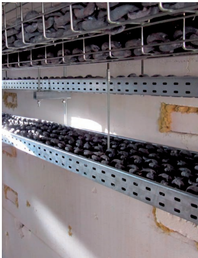
Kabeļu rene ar lielu mehānisko slodzi, paredzēta...
