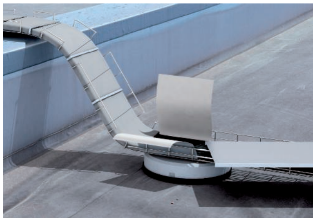
Pāri ugunsdrošības sienai izvadīti bandāžā nostiprināti vadi
